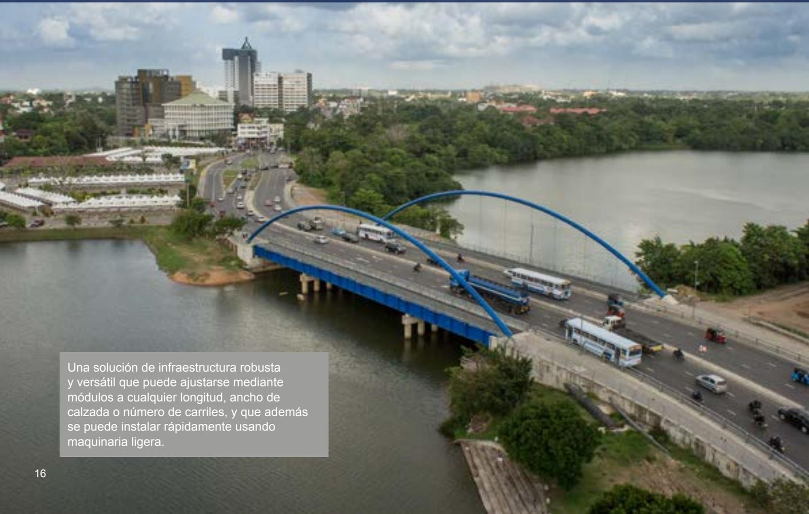
Una solución de infraestructura robusta y versátil que puede ajustarse mediante módulos a cualquier longitud, ancho de calzada o número de carriles, y que además se puede instalar rápidamente usando maquinaria ligera.
