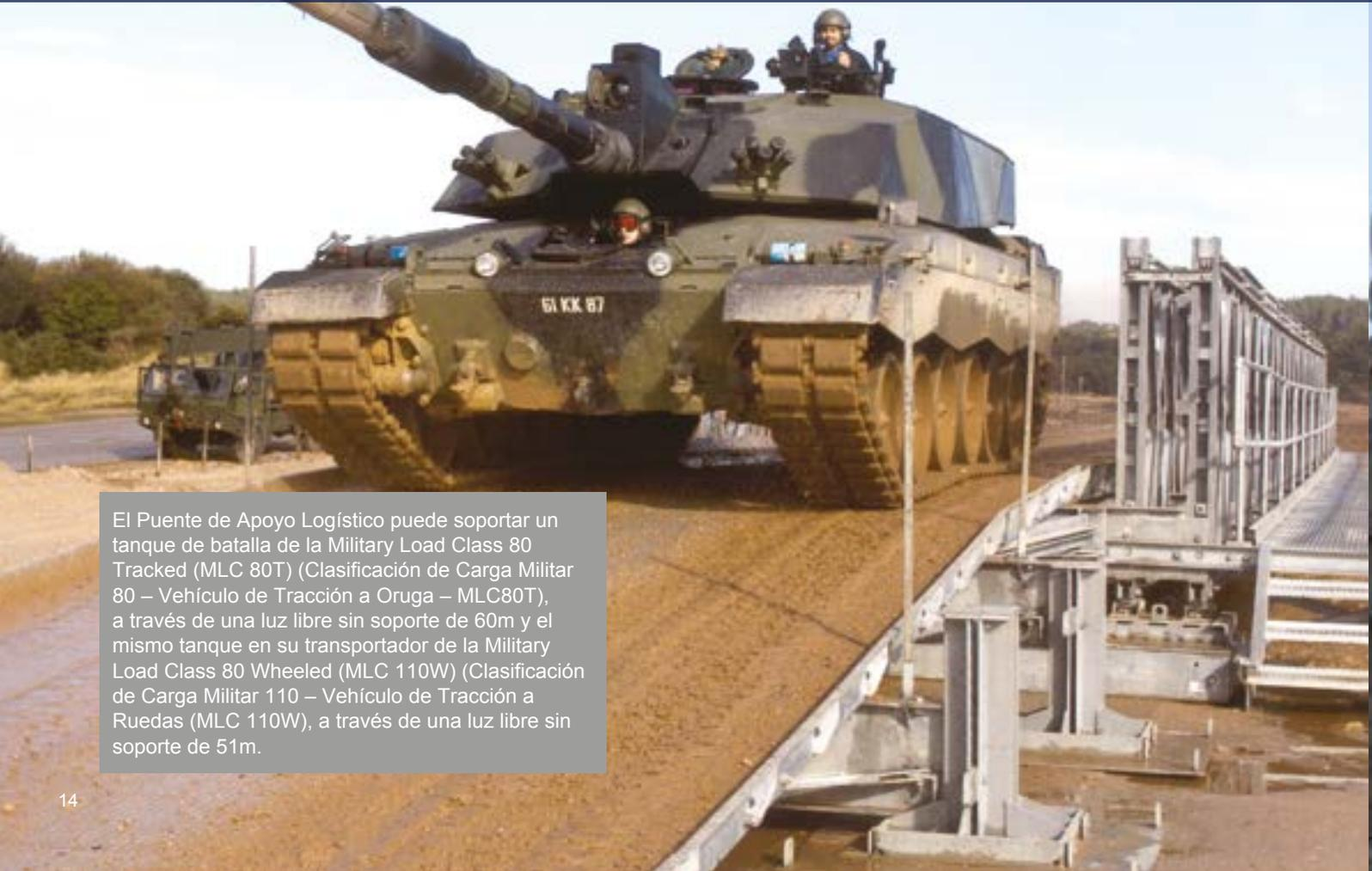
El Puente de Apoyo Logístico puede soportar un tanque de batalla de la Military Load Class 80 Tracked (MLC 80T) (Clasificación de Carga Militar 80 – Vehículo de Tracción a Oruga – MLC80T), a través de una luz libre sin soporte de 60m y el mismo tanque en su transportador de la Military Load Class 80 Wheeled (MLC 110W) (Clasificación de Carga Militar 110 – Vehículo de Tracción a Ruedas (MLC 110W), a través de una luz libre sin soporte de 51m.
