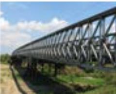
Armadura                           | Las unidades Delta son atornilladas Pernos precargados | No se requiere de soldadura en el lugar                             | Maquinaria pequeña          | ✓                       | ✓        | ✓            | 4.50                                 |
