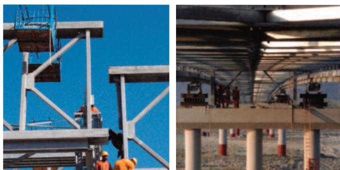
**Topo:** lançamento da ponte com dianteira acoplada.
