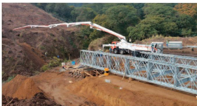
**Supérieure :** mise en place d'éléments de tablier antidérapants sur le pont Mabey Compact 200.
